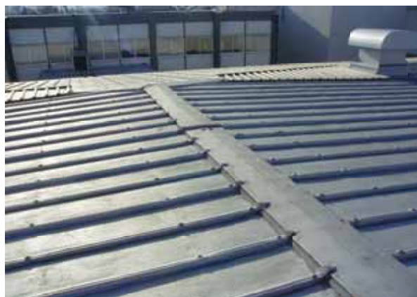
下地と新規の棟の取付け状況
