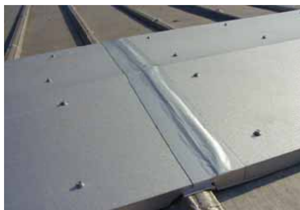
専用プライマー、変性シリコンをぬり コーキング劣化防止用のアルミテープを貼る
