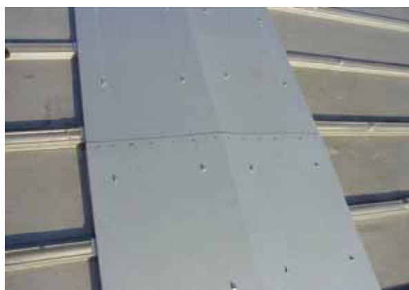
専用プライマー、変性シリコンをぬり コーキング劣化防止用のアルミテープを貼る
