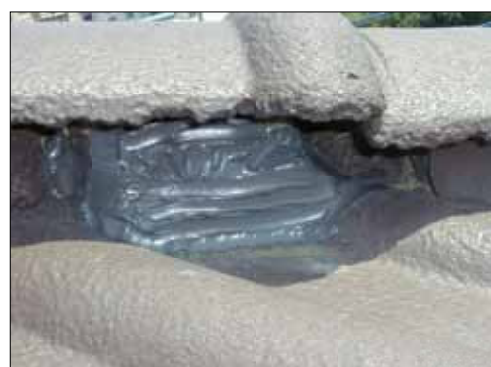
各所の瓦破損状況
