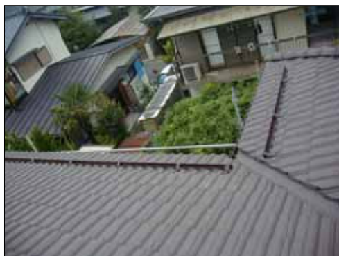
雪止めの施工状況
