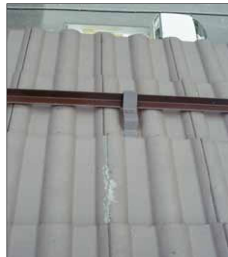
瓦の補修（コンクリートボンド使用）
