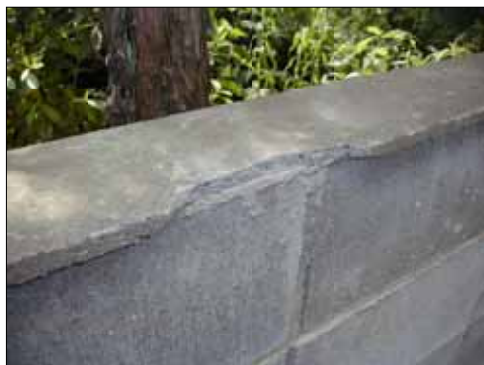
西側のブロックの破損状況
