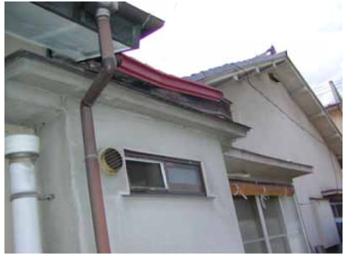
東側の納まり 赤い部分が新しく施工した所です
