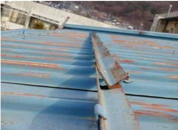
屋根の軒先の状況 矢印のように雨水が落ちていました。 風を伴う雨の場合には建物側に入っていたと思います
