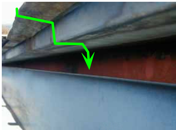
屋根の軒先の状況 矢印のように雨水が落ちていました。 風を伴う雨の場合には建物側に入っていたと思います
