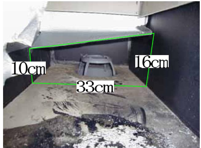
上の写真の様に落し口に向いていた排水方向を下
