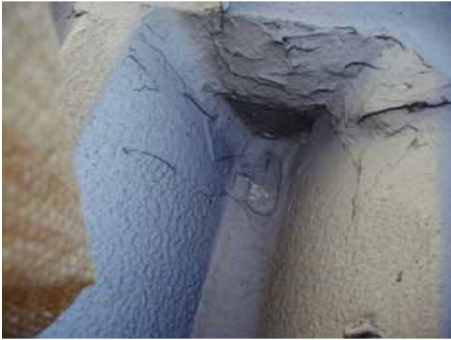
下部の写真 雨漏り箇所上部補修後の写真
